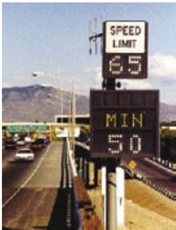
写真－1 可変速度規制 (表示している数字は、mile/h) ( http://its.dot.gov/ より)
