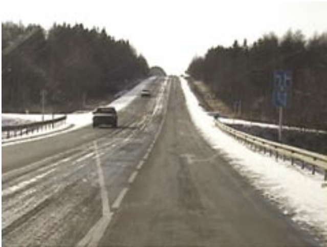
写真－3 サハリン州内の2+1車線の連邦道路 (郊外部の道路) (撮影：著者(宗広))
