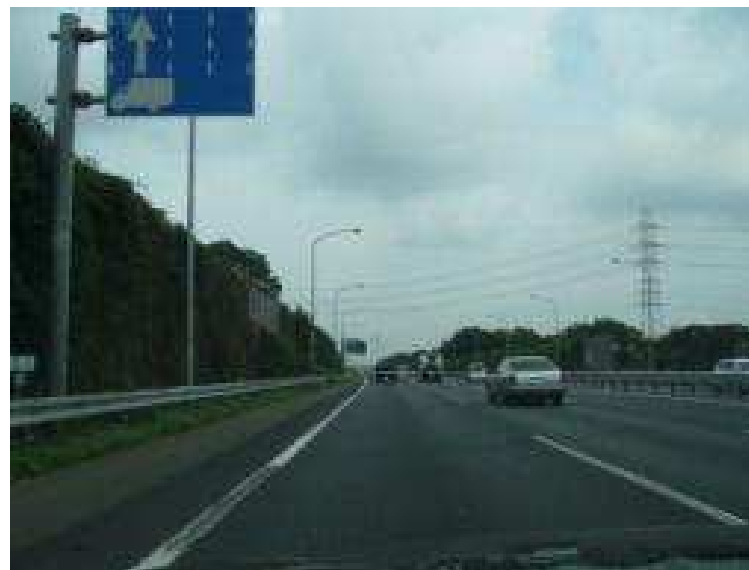
(例) 関越自動車道
